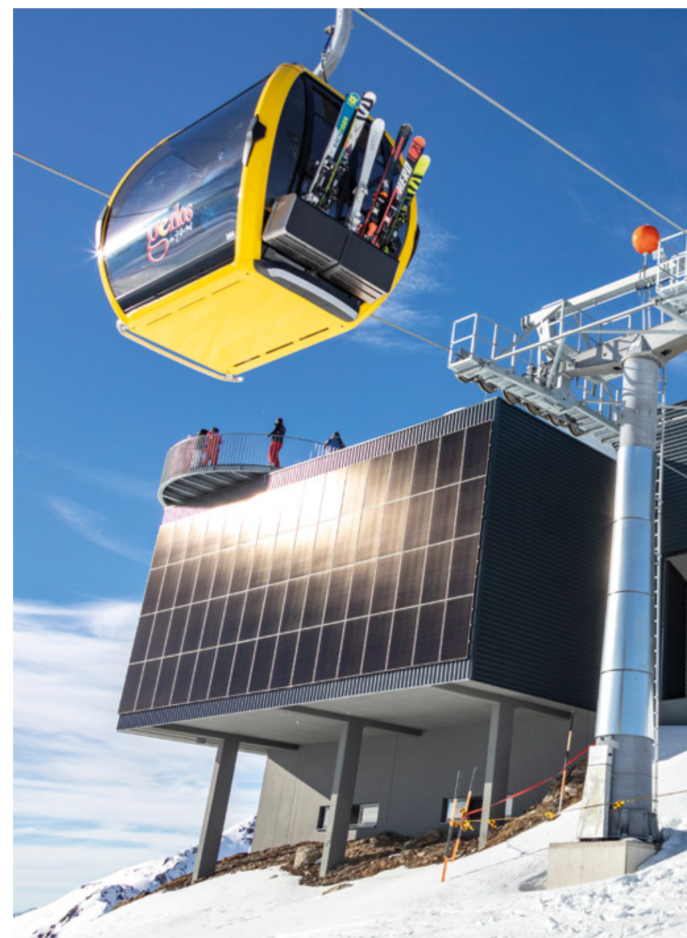
Die Stuanmandlbahn in Gerlos ist die neueste Ergänzung zu den acht PV-Systemen der Zillertal Arena.
