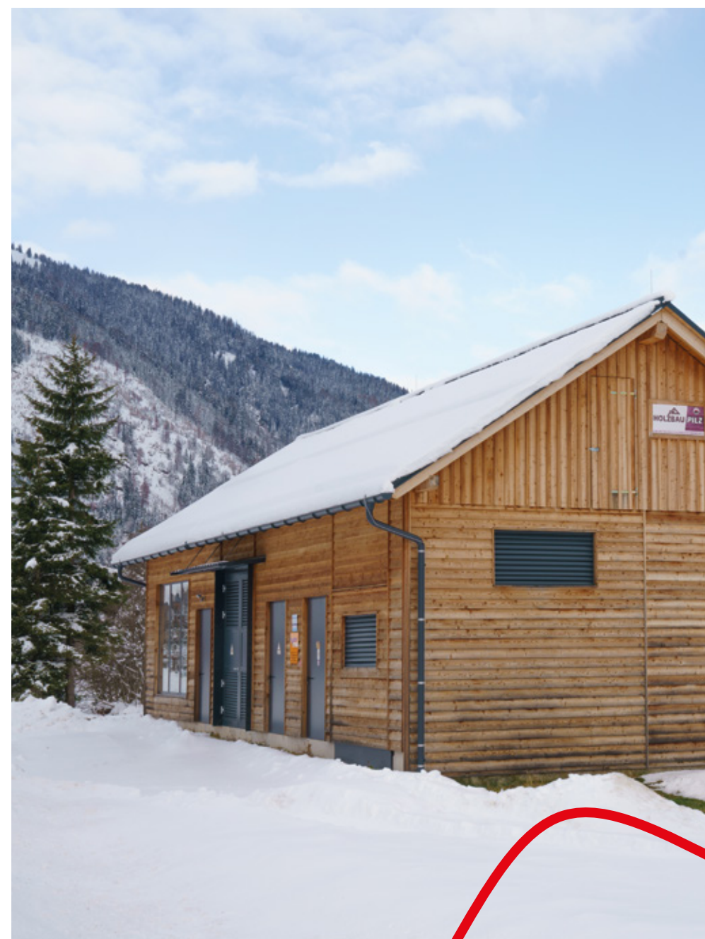
Das Schneekraftwerk fügt sich nahtlos in die Talstation der Riesneralm ein.
